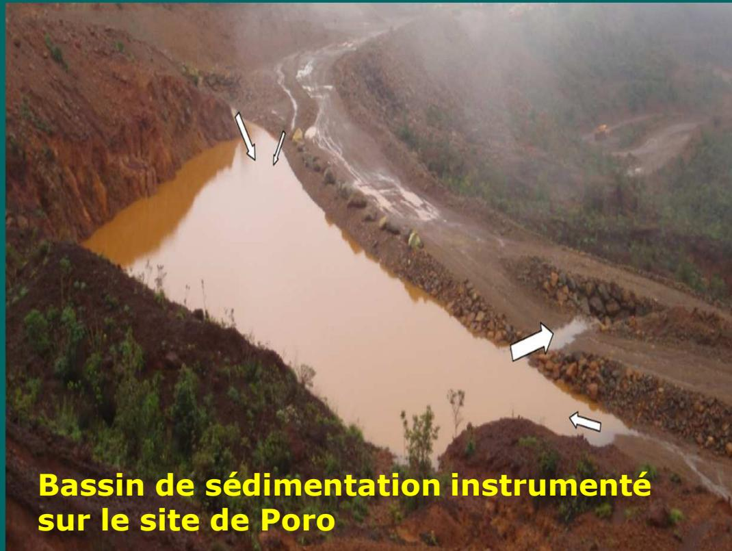
**Bassin de sédimentation instrumenté sur le site de Poro**
