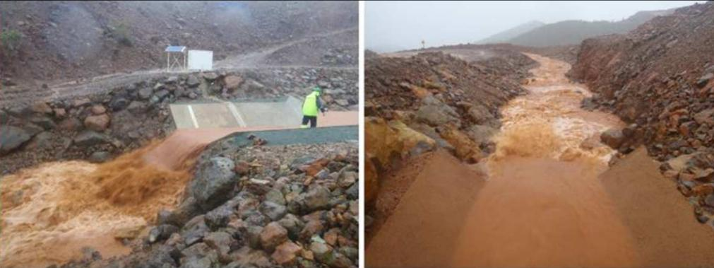
A gauche: Seuil aval pendant une crue. A droite: Ecoulement à la sortie du seuil amont pendant une crue.
