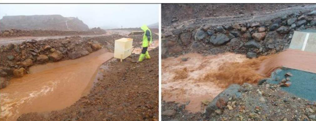
A gauche: Seuil amont pendant une crue. A droite: Ecoulement à la sortie du seuil aval pendant une crue.
