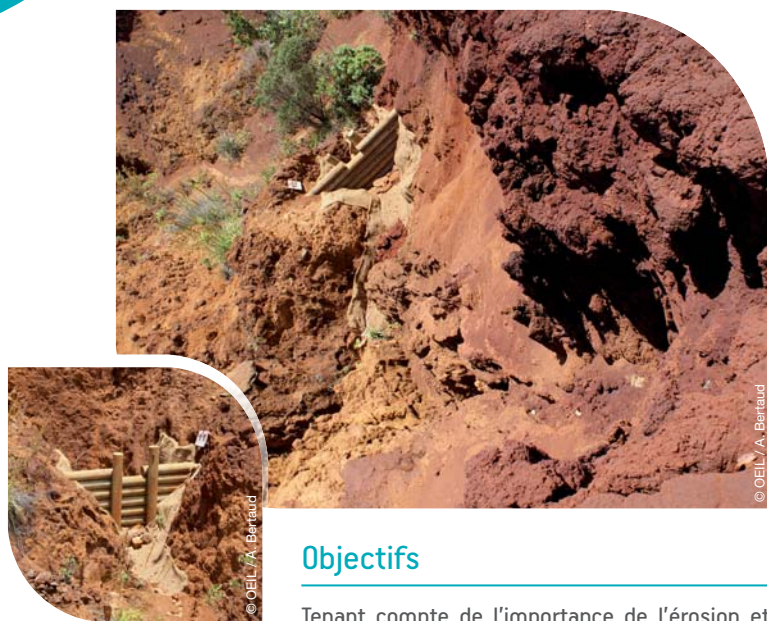
Ouvrage de gestion de l'érosion sur un lavaka de La Coulée.
