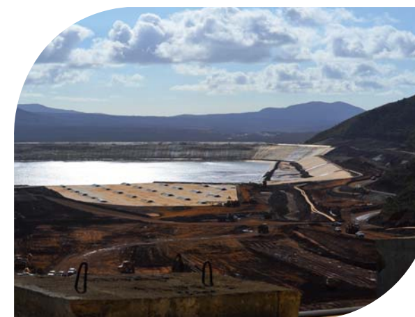
Vue sur l'aire de stockage des résidus de Vale Nouvelle-Calédonie
