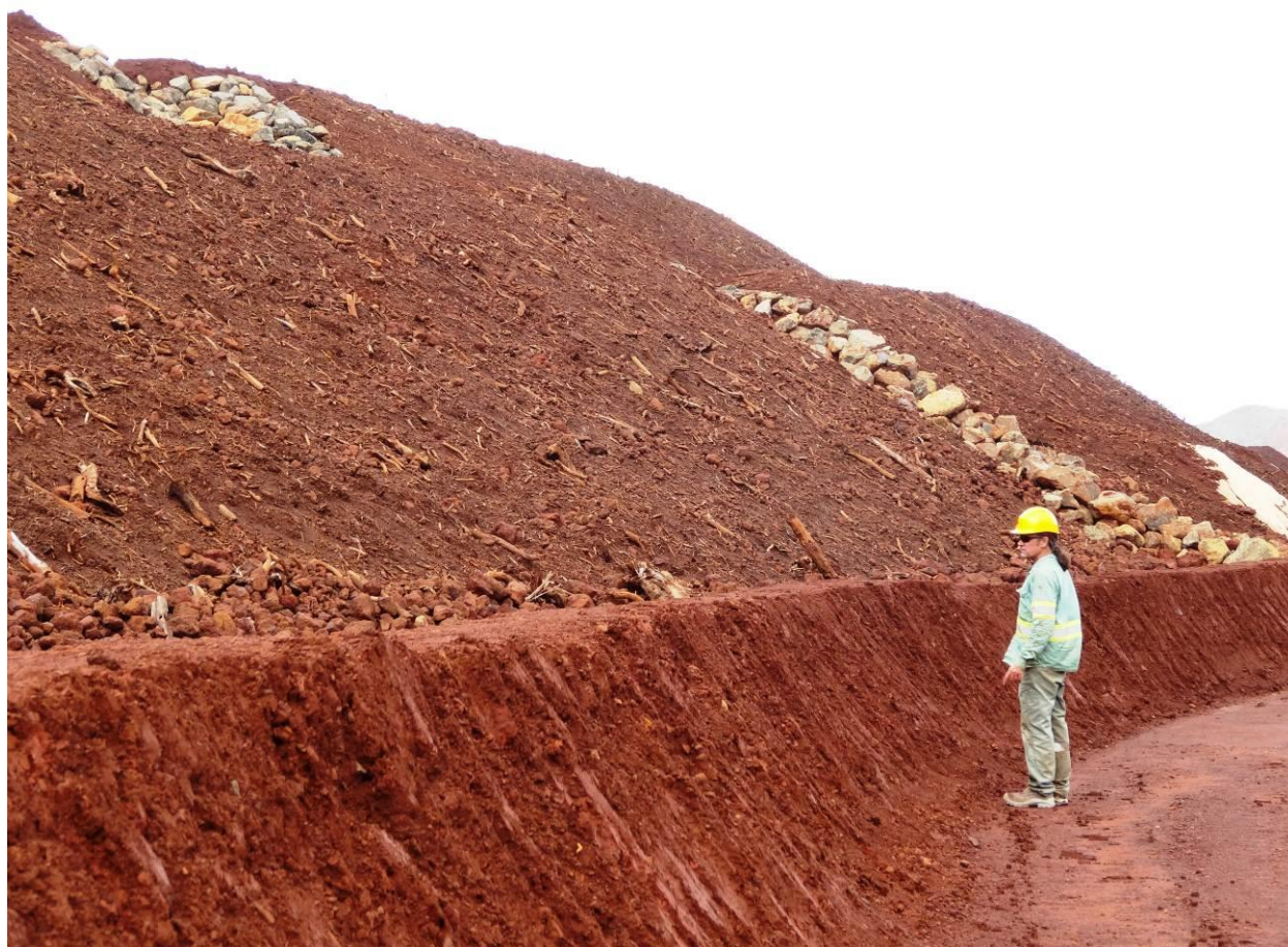
Etalage de top-soil sur la verse SMLT, décembre 2015
