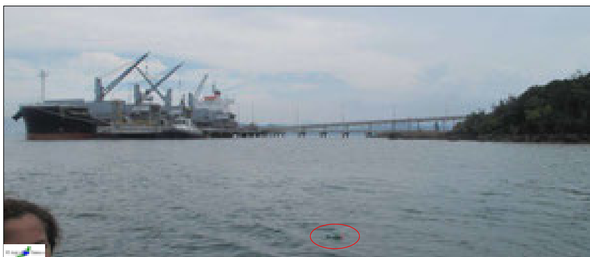
Photo n°010 : Position en surface par rapport aux structures portuaires (ST03)
