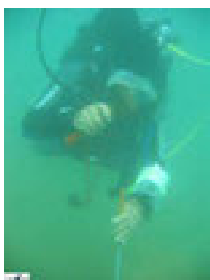
Photo n°01 : Mise en place d'un piquet
