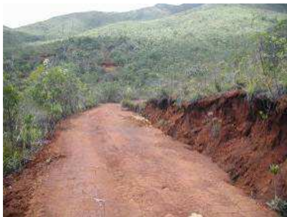
Figure 1 : 1er tronçon avant travaux
