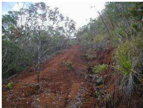
Figure 2 : deuxième tronçon avant travaux
