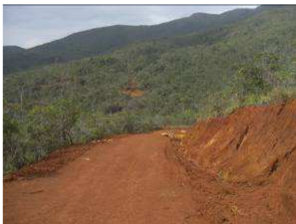
Figure 3 : 1er tronçon après travaux
