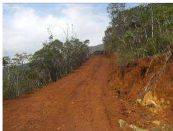
Figure 4 : deuxième tronçon après travaux
