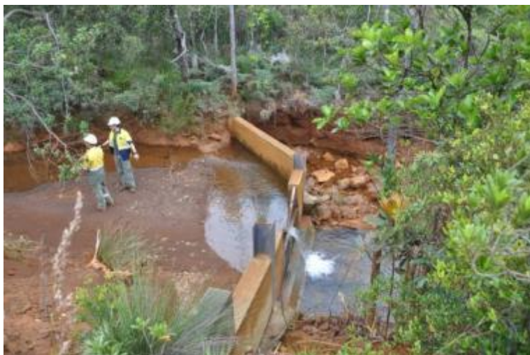
Photographie 1. Piège à sédiment sur la Kwé Est. Site de Vale NC (Asconit, 2014)
