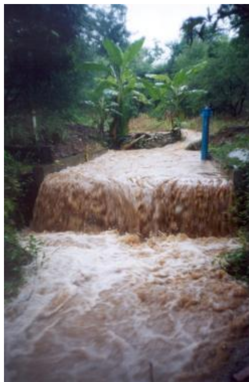
Photographie 5. Piège à sédiment en ravine (Jean Louis Janeau, IRD prise sur le site du projet MSEC à Phrae en Thaïlande ; Valentin et al., 2008.
