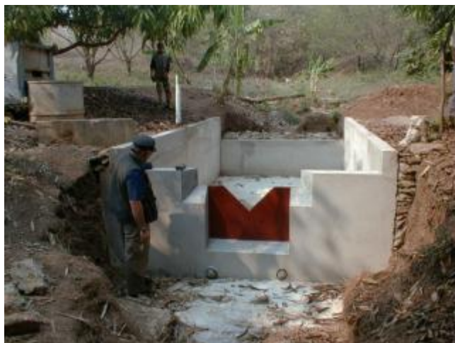
Photographie 5. Piège à sédiment en ravine (Jean Louis Janeau, IRD prise sur le site du projet MSEC à Phrae en Thaïlande ; Valentin et al., 2008.
