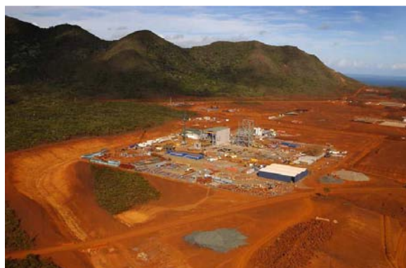
Photo2 : La centrale de Prony Energies
