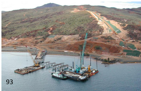
Photos 93 et 94 : Vues aériennes du port constitué de ses deux quais montés sur pieux (93) dont l'un est relié à l'usine par un convoyeur (94).
