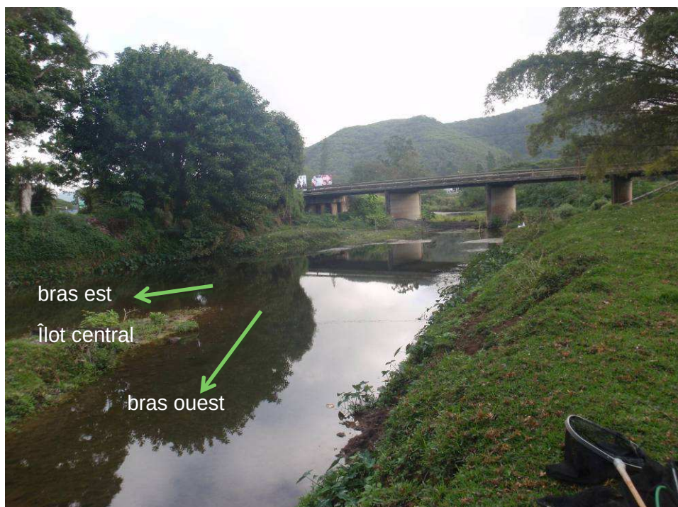
Photo 8 : La station FONW- 050.
