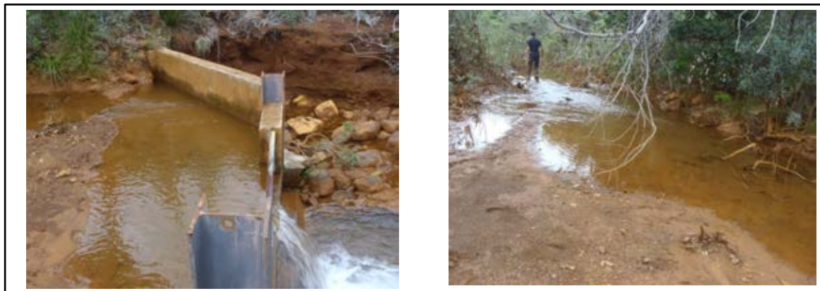
Planche photos 25 : Barrage sur la Kwé Est et phénomène de sédimentation (à droite)
