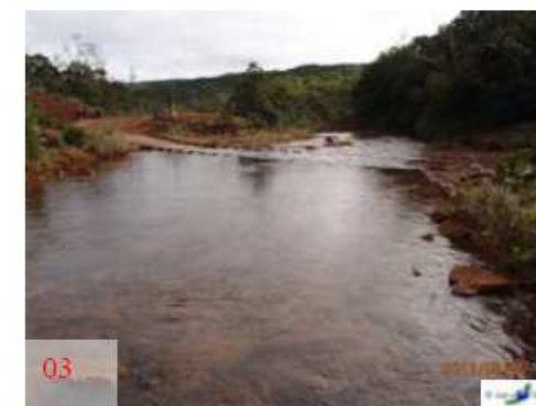
Vue vers l'aval
