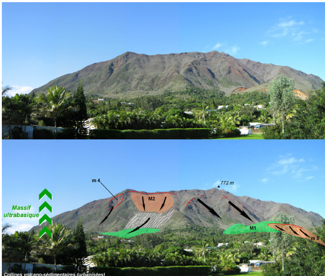
Illustration III.2.4 C - Localisation dans le paysage de quelques mouvements de terrain du versant SO du massif du Mont Dore. Mouvements anciens : M1 (dôme du Vallon Dore), M2 (ancien glissement stabilisé, estompé); Mouvements actuels : m 4 (éboulements), m 5 (glissement Mille & Berton, 1988)
